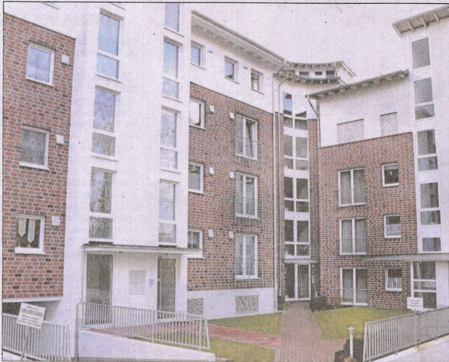
Drei der vier Abschnitte der „Residenz im Kurpark“ sind fertig, im April wird mit dem Bau des vierten und letzten Abschnitts begonnen. - Foto: Tomicek
